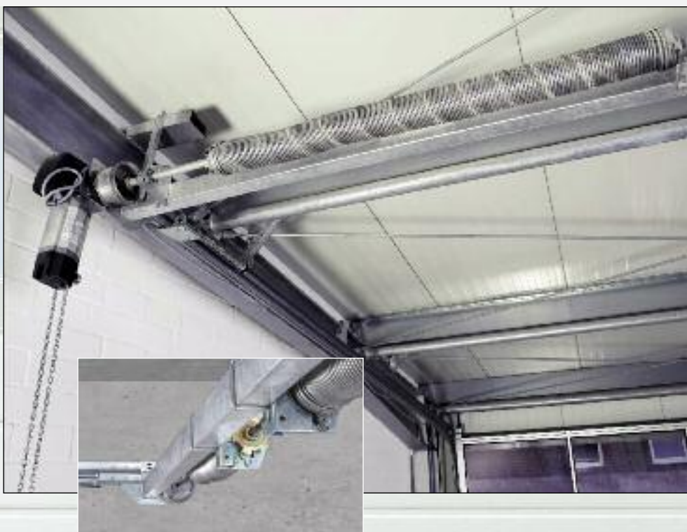
Federwelle über Spezialklammer mit dem verzinkten Trägerrohr verbunden.
