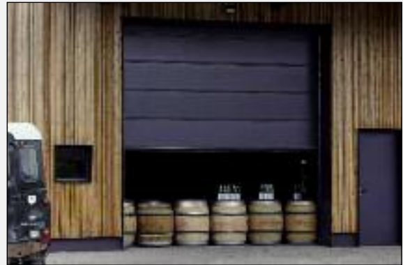
Sectionaltor SW „ohne Sicke“, als Abschluss eines Weinlagers.
