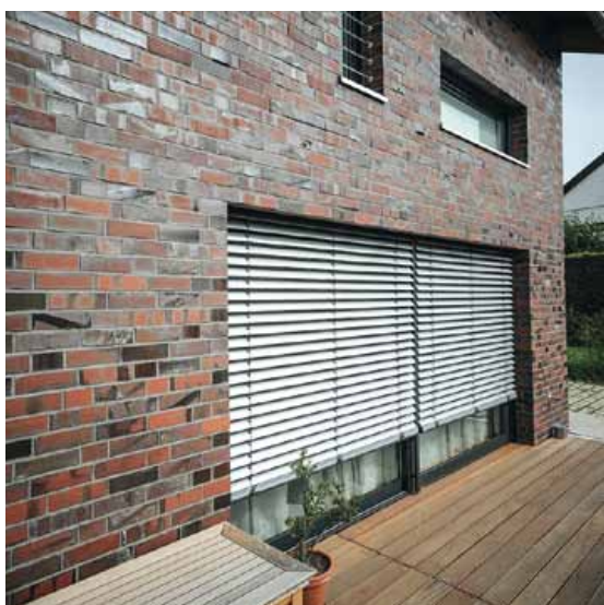
Tageslicht perfekt dosieren, ohne die Außenwelt auszusperren
